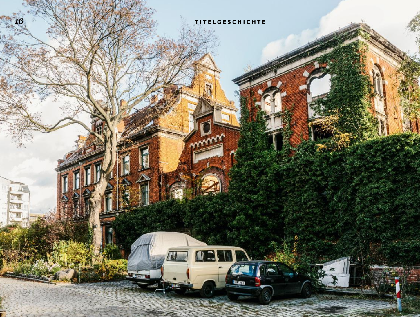
Die Ruhe vor der Sanierung: Die Planungen für die Sanierung der Wiesenburg haben bereits begonnen. Die Gebäude wurden Ende des 19. Jahrhunderts gebaut und sollen ihren Charme behalten
