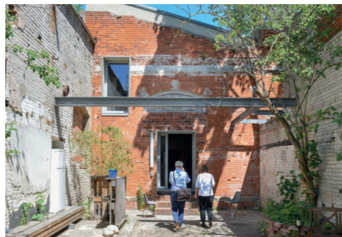
Der Zugang zur Tanzhalle. Sie wird künftig auch vom grünen Innenhof erschlossen.
