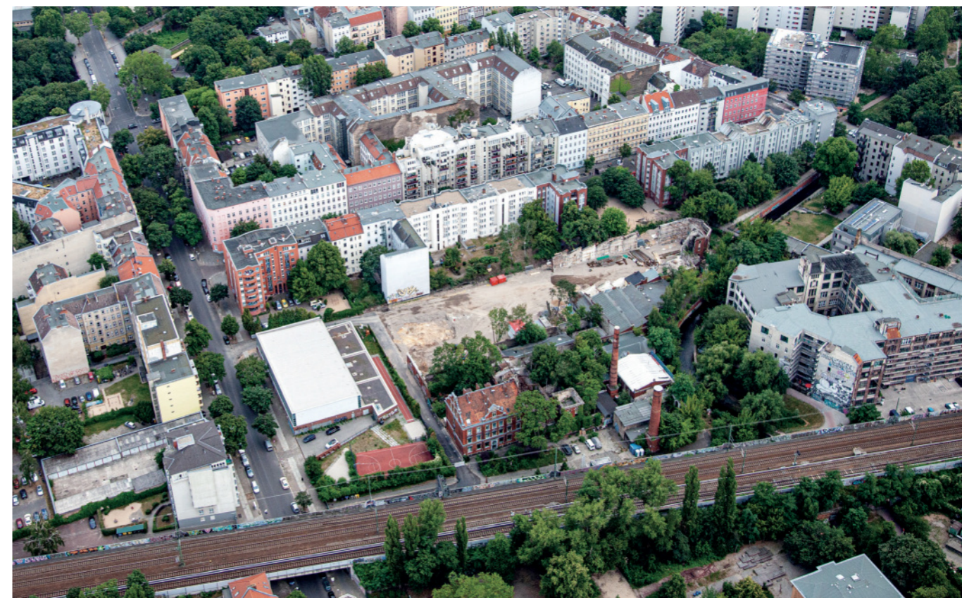
Luftaufnahme der Wiesenburg aus dem Jahr 2019. Die Bauarbeiten für den Neubau haben im April 2019 begonnen.
