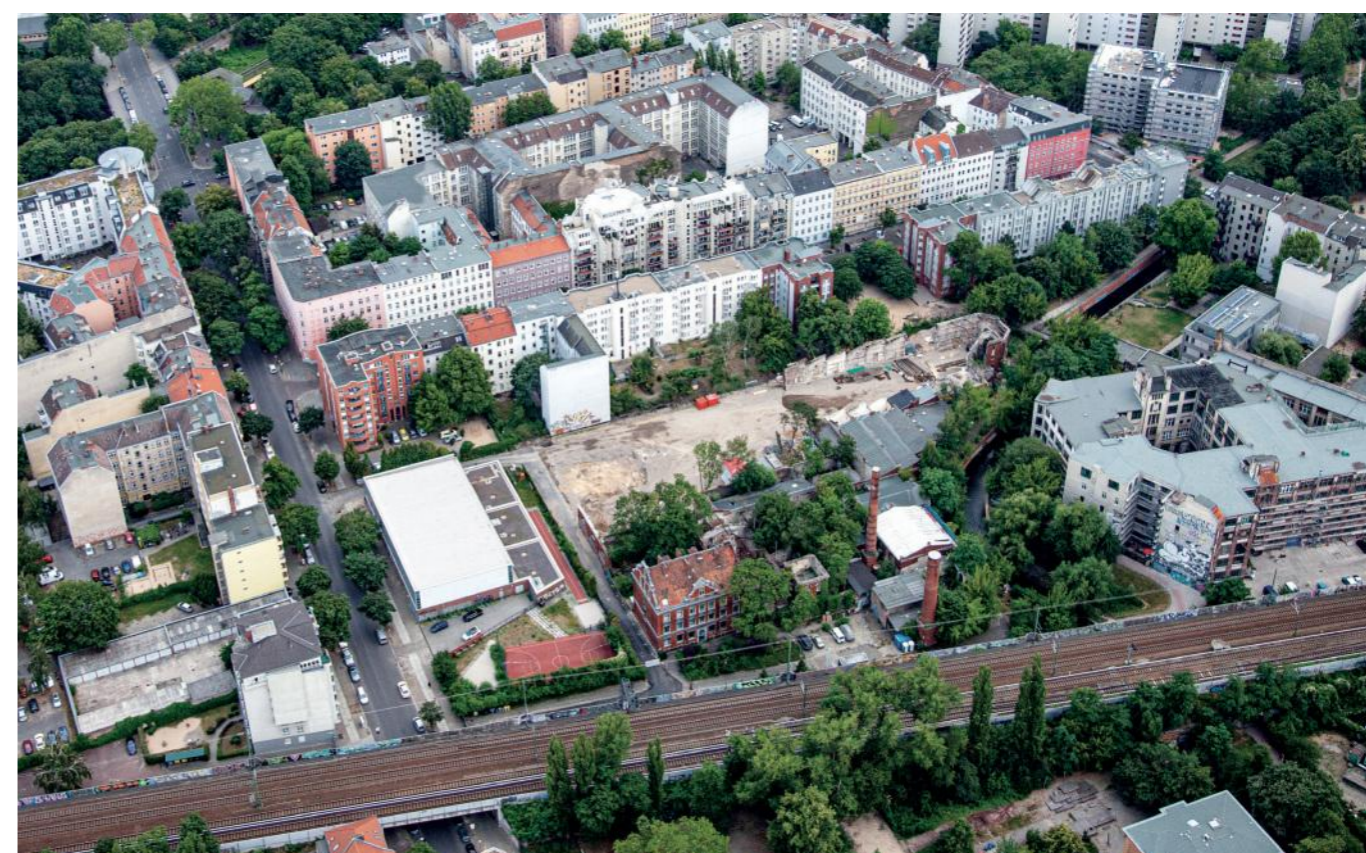
Luftaufnahme der Wiesenburg aus dem Jahr 2019. Die Bauarbeiten für den Neubau haben im April 2019 begonnen.
