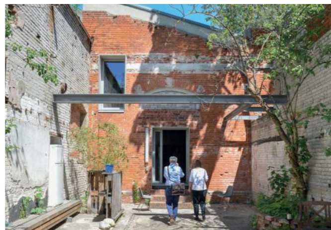
Der Zugang zur Tanzhalle. Sie wird künftig auch vom grünen Innenhof erschlossen.
