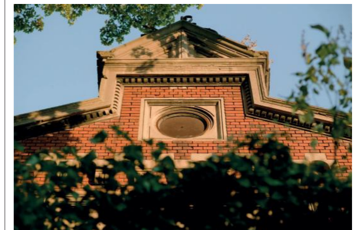
Der Giebel der Sammelhalle wurde aus Kunststein gefertigt
