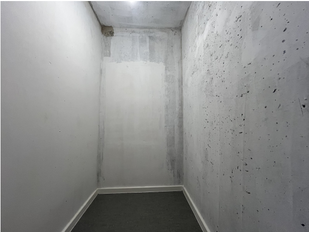
Abstellcke im Flur
