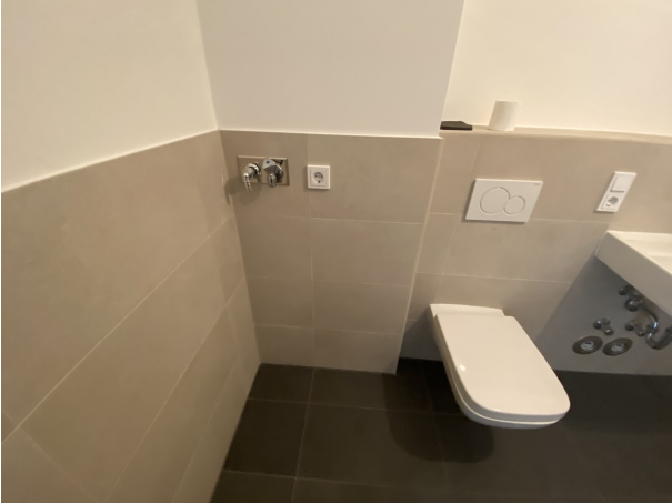
Waschmaschinenanschluss
