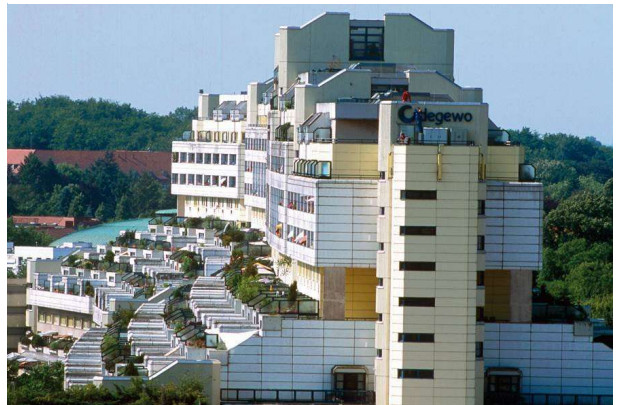
Foto Haus Schlange
