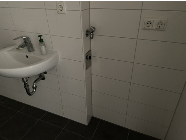
Waschmaschinenanschluss
